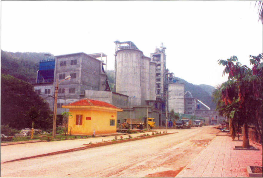
Công ty cổ phần xi măng Hoàng Long - xã Thanh Nghị khởi công xây dựng năm 2003 (ảnh chụp năm 2005).
